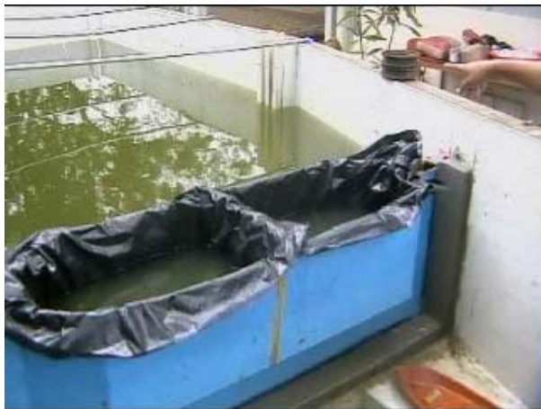
Figura 19. Compuerta hundida y proveyendo estanqueidad al dique
