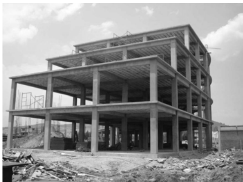
Figura 2. Fachada oriente del edificio.
