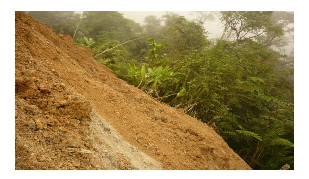
**Fotografía 2.**- Se muestra la descarga de los desechos sólidos mineros en el talud de los drenajes sin utilizar obras de protección contra la erosión y estabilidad del talud. Los residuos sólidos son descargados en las laderas del terreno y afectan directamente a la vegetación y calidad de las aguas superficiales.
