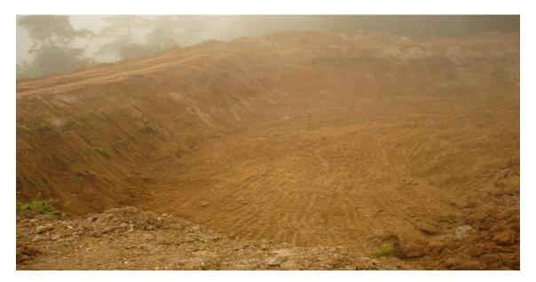
Fotografía 1.- En esta fotografía se observa la excavación de una piscina donde se coloca el material sólido que representa el residuo sólido obtenido como relave de las plantas de beneficio utilizadas en la extracción de oro. El material de los diques y cimentación de la piscina es el terreno natural que no tiene ninguna protección contra las infiltraciones de los lixiviados que forman parte de los desechos, lo que conduce a la contaminación del suelo y aguas subterráneas.
