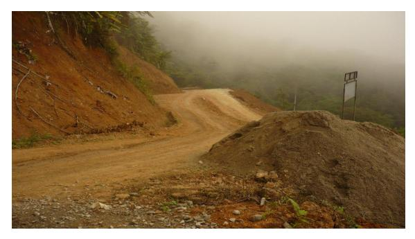
Fotografía 4.- residuos solidos mineros colocados en el borde del camino sin ninguna protección contra la erosión y control ambiental. Los residuos sólidos tienen alto contenido de minerales tóxicos que representan alto riesgo para el medio ambiente.
